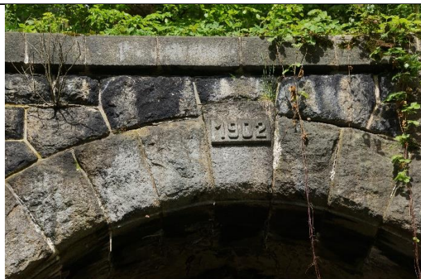
Obr. 7 Porušené spárování, výluhy sintru
