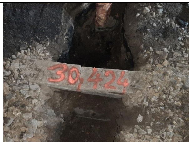
Obr. 5: Kopaná sonda km 30,424: Pod kabelovodem zastižena boční tunelová drenáž.
