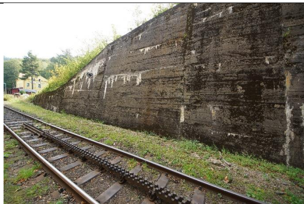
Obr. 11 Průsaky a povrchová degradace betonu
