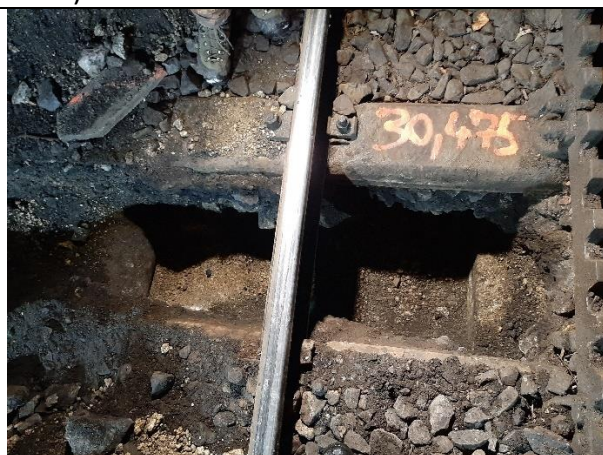
Obr. 4 Kopaná sonda km 30,475: vlevo drenážní potrubí, vpravo střední tunelová stoka
