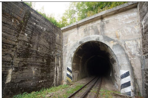
Obr. 8 Průsaky portálovou stěnou
